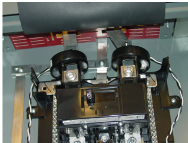
Figure / Figura 4: Install Current Transformers / Instalación de los transformadores de corriente
